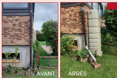
Exemple de débranchement et mise en place d'une cuve de récupération des eaux pluviales
